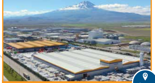
PVC-U ve PP-R Sistem Üretim Tesisi
