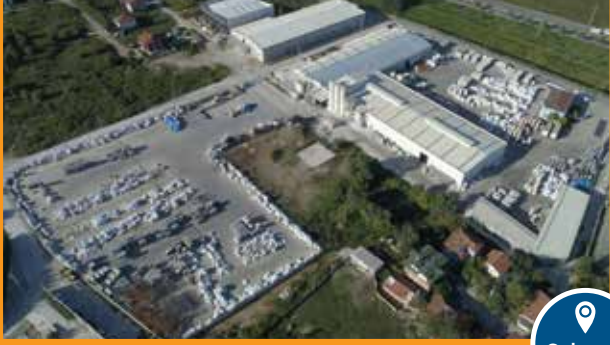
PVC-U Sistem Üretim Tesisi
